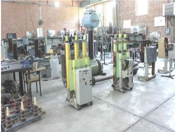
شکل ۳- کارگاه اجزا پست
