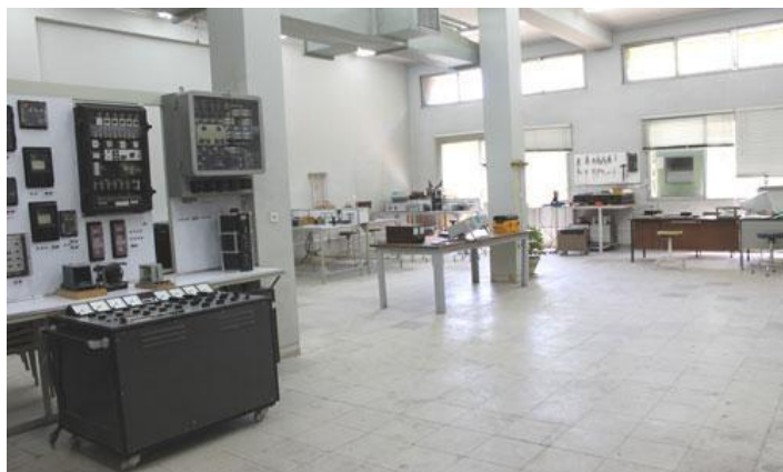
شکل ۹- آزمایشگاه رله و حفاظت الکتریکی
